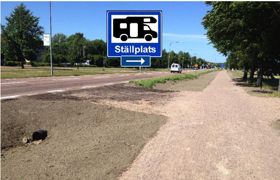
Ny infart har precis byggts till området. Bara att sätta upp skylten.
